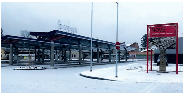
Výstavba moderního autobusového nádraží v Šumperku je ve finále. Téměř přesně po roce provozu na náhradním stanovišti se autobusy vrátí na původní místo. Foto: -pk-
