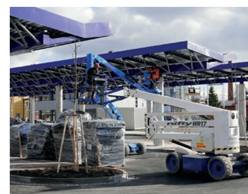
Koncem listopadu se specializovaná firma pustila do realizace zelených střech nad nástupními ostrůvky. Foto: -pk-
