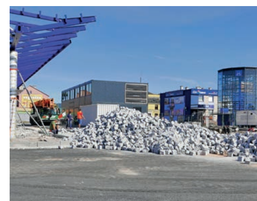
Nová výpravní budova při Jesenické ulici vyrostla loni v září během dvou dnů. Foto: -pk-
