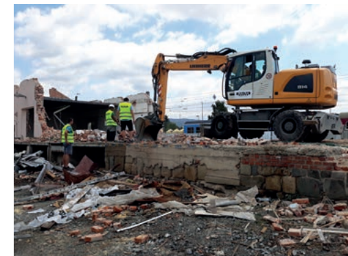
Modernizaci lokality u autobusového nádraží odstartovaly v červenci 2019 demoliční práce v části u vlakového nádraží. Foto: -ger-
