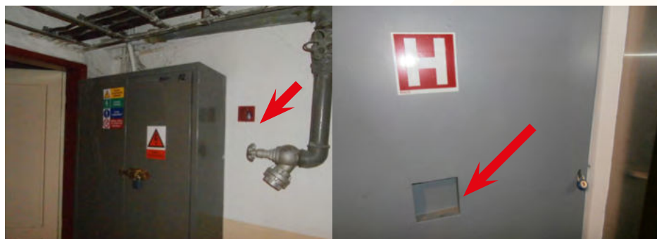
Rozvodná skříň s hlavním vypínačem elektrické energie s bezpečnostní krabičkou a klíčem pro její odemčení (vlevo), hydrant uzamčený visacím zámekem a chybějícím klíčem (vpravo)
