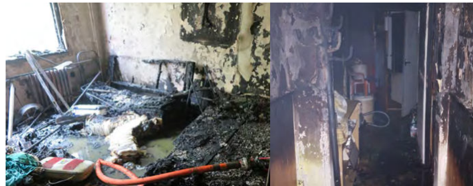
Na fotografiích lze vidět, jak vypadá byt po požáru stolního počítače (vlevo) a po zahoření vrtulového ventilátoru (vpravo).
